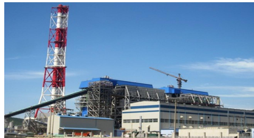
Hình: Công trường nhà máy điện Nghi Sơn Photo © dantri.com
