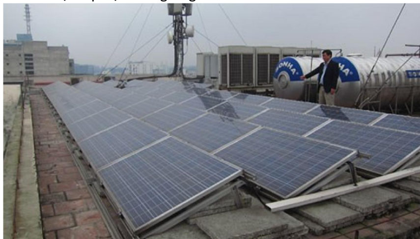
Hình: Dàn pin mặt trời nối lưới 12kW trên nóc trụ sở Bộ Công thương, Photo © Thành Long (Báo Thanh niên)
